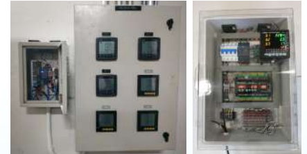
ภาพติดตั้ง และกล่องต้นแบบใช้งาน อ่านค่าพลังงานไฟฟ้า (Onsite-Installation)
