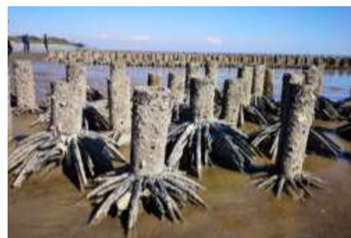
รูปที่ 3 สภาพโครงการเทียมซีออสหลังติดตั้ง 5 ปี
