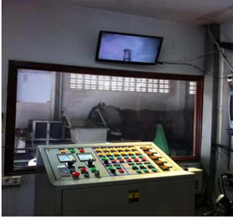
รูปที่ 1-2 ห้องควบคุมการเผาทำลายขยะและของเสียอันตราย
