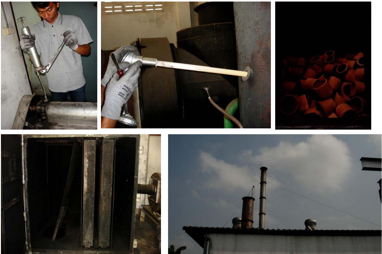
รูปที่ 5-1 การตรวจเช็คและบำรุงรักษาระบบควบคุมมลพิษทางอากาศ
