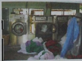
น้ำร้อนจากระบบจ่ายเข้ากับ เครื่องซักผ้าติดเชื้อ
